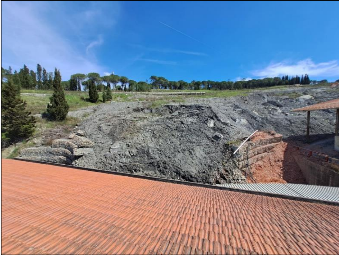
Figura 3 – situazione a pochi giorni dal collasso della gabbionata alla base del fronte nel 2024
